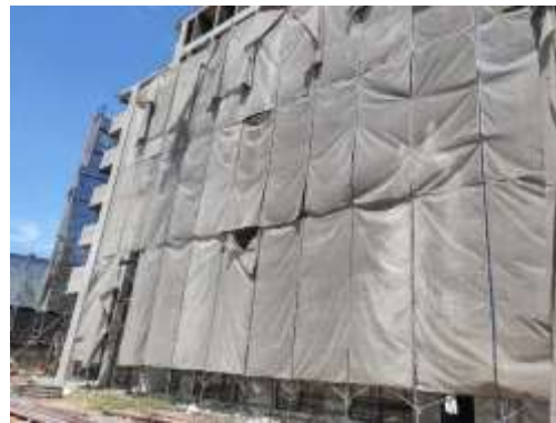
รูปที่ 3-8 ผ้าใบกันป้องกันฝุ่น (Mesh sheet)
