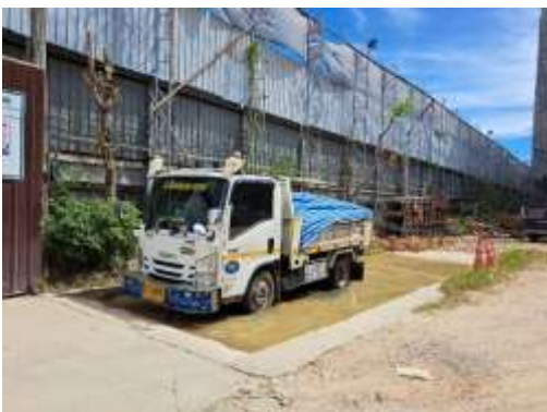
รูปที่ 3-6 พื้นที่สำหรับล้างล้อรถ และการล้างทำความสะอาดล้อรถ
