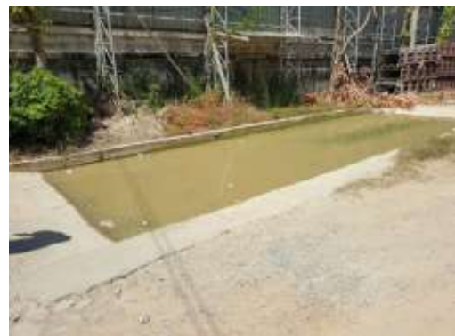
รูปที่ 3-6 พื้นที่สำหรับล้างล้อรถ และการล้างทำความสะอาดล้อรถ
